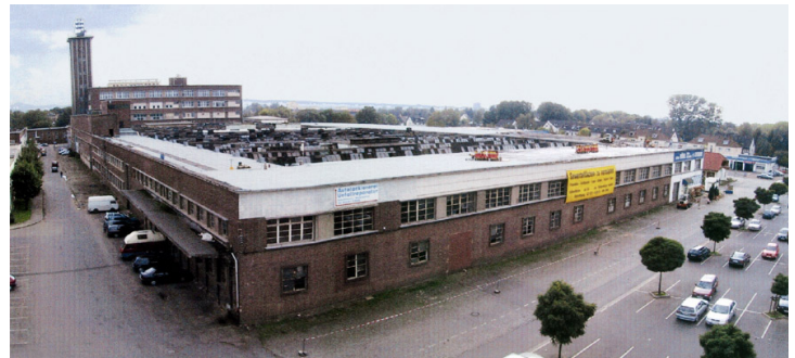
IST-ZUSTAND VOR UMBAU, SANIERUNG UND NEUBAU
